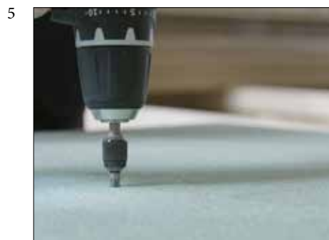
5 Gulvplatene festes til alle understøttelser med skruer
