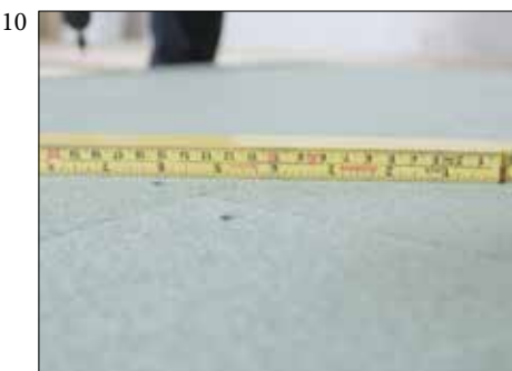
10 Skruer skal forsenkes 2-3 mm ned i platen. Hullene må ikke sparkles da hodet kan komme opp når bjelkene krymper.
