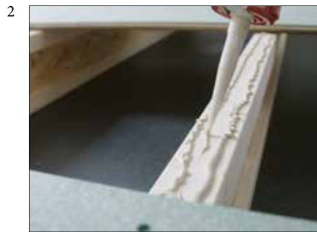
2 Min. 2 limstrenger på bjelkene.
