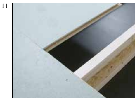
11 Om ønskelig kan disse platene skjøtes mellom bjelkelaget.
