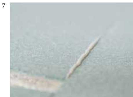
7 Når platene er klikket sammen skal overflødig lim tyte opp i skjøten.
